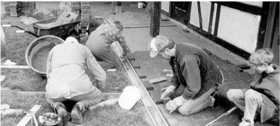
Verlegen der Pflastersteine auf die bereits erstellte Unterfüllung. Foto: Helmut Raum / Asgard
